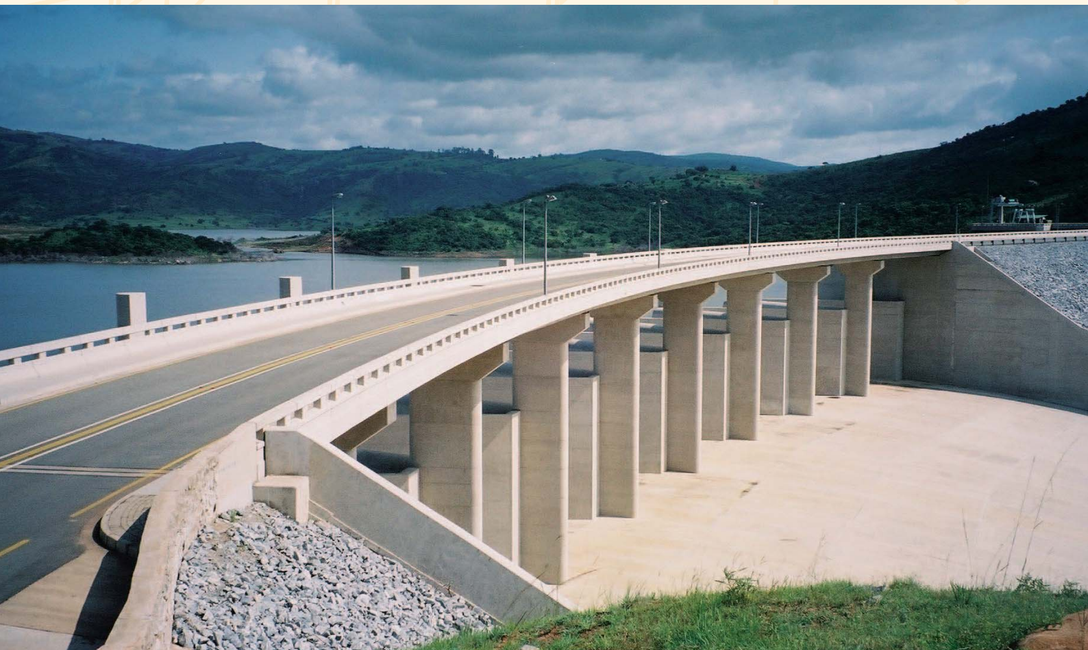
Maguga Dam, Swaziland (史瓦濟蘭-東非) 工程顧問：Maguga Dam Joint Ventures. 設計工程師：Pieter Louw
